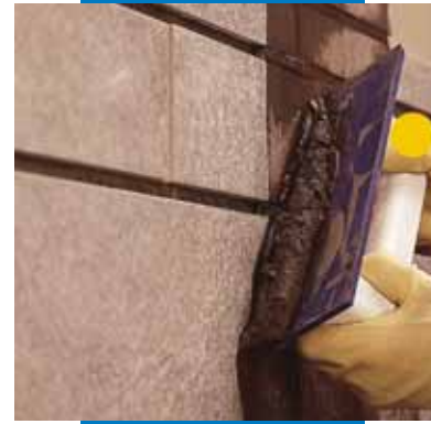
Wandverfugung mit Gummifugbrett
