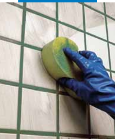
Waschen der Fuge mit einem Schwamm
