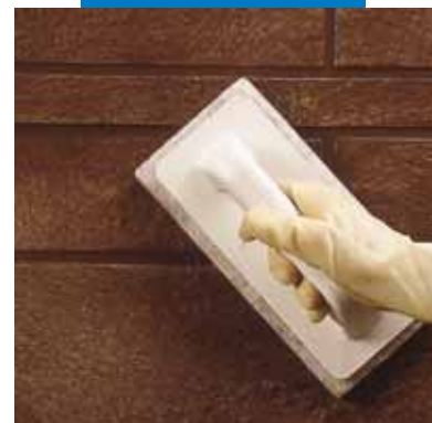
Waschen des angezogenen Fugmörtels mit einem Schwammbrett
