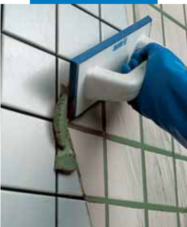
Wandverfugung mit Gummifugbrett
