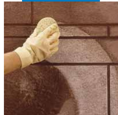
Endreinigung des Fugmörtels mit einem Schwamm
