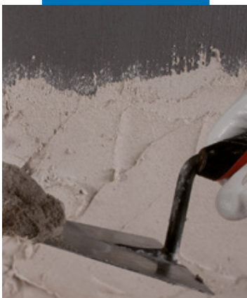
Aufbringen eines Putzes auf Eco Prim Grip
