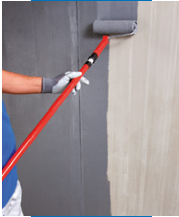
Aufrollen von Eco Prim Grip auf Beton
