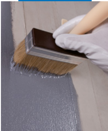
Aufstreichen von Eco Prim Grip auf Beton
